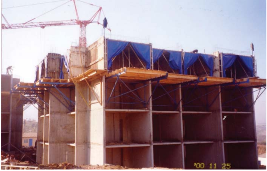
(a) Beton Döküm Aşamasında
