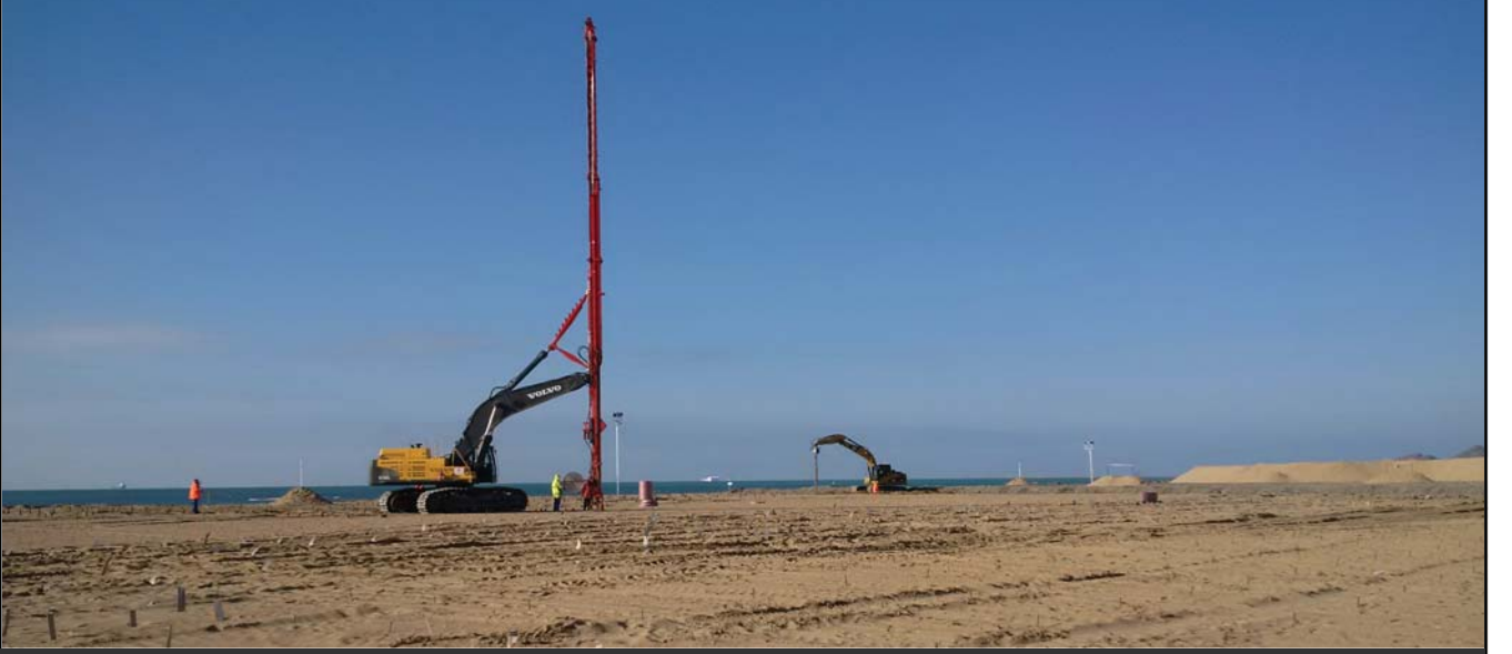
Türkmenbaşı Port, Zemin Islah İşleri, Türkmenistan
